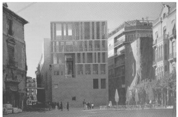
16. Rathaus (1992–98), Murcia, Fassade auf die Plaza Cardinal Belluga
