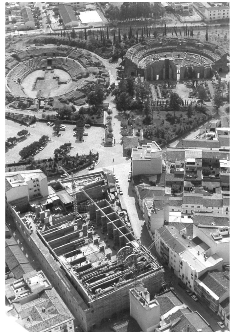
29. Museo Nacional de Arte Romano, Luftbild (Baustelle)
