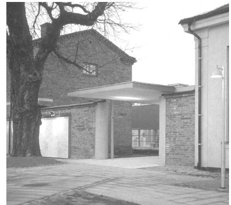
122. Moderna Museet, Eingangssituation im Westen
