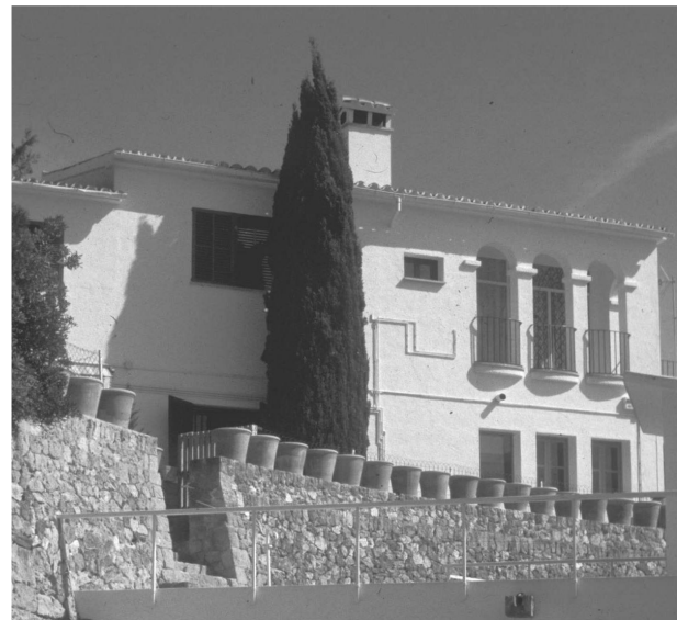
57. Miró's Wohnhaus, Cala Major/Mallorca
