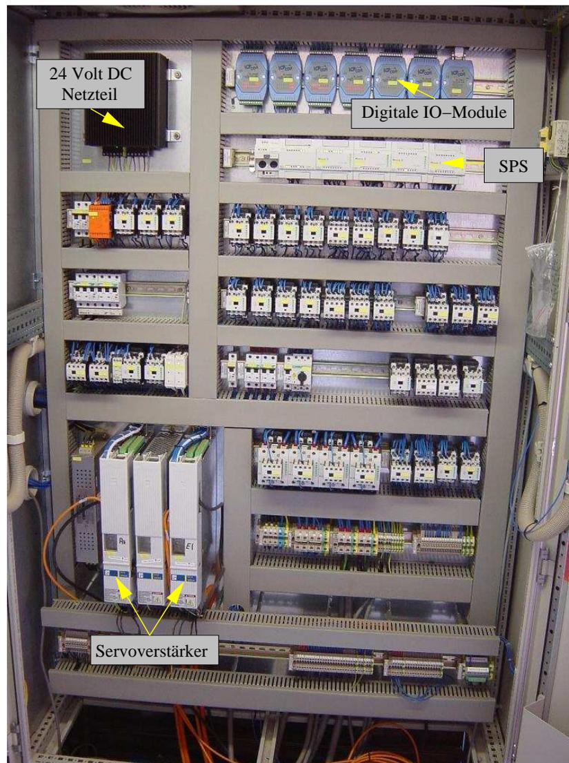
Abbildung 2.15: Schaltschrank mit Servoverstärkern und Kommunikationsmodulen, sowie 24 VDC-Versorgung und Speicherprogrammierbarer Steuerung SPS für DC und Notfahrt-Kontrolle.
