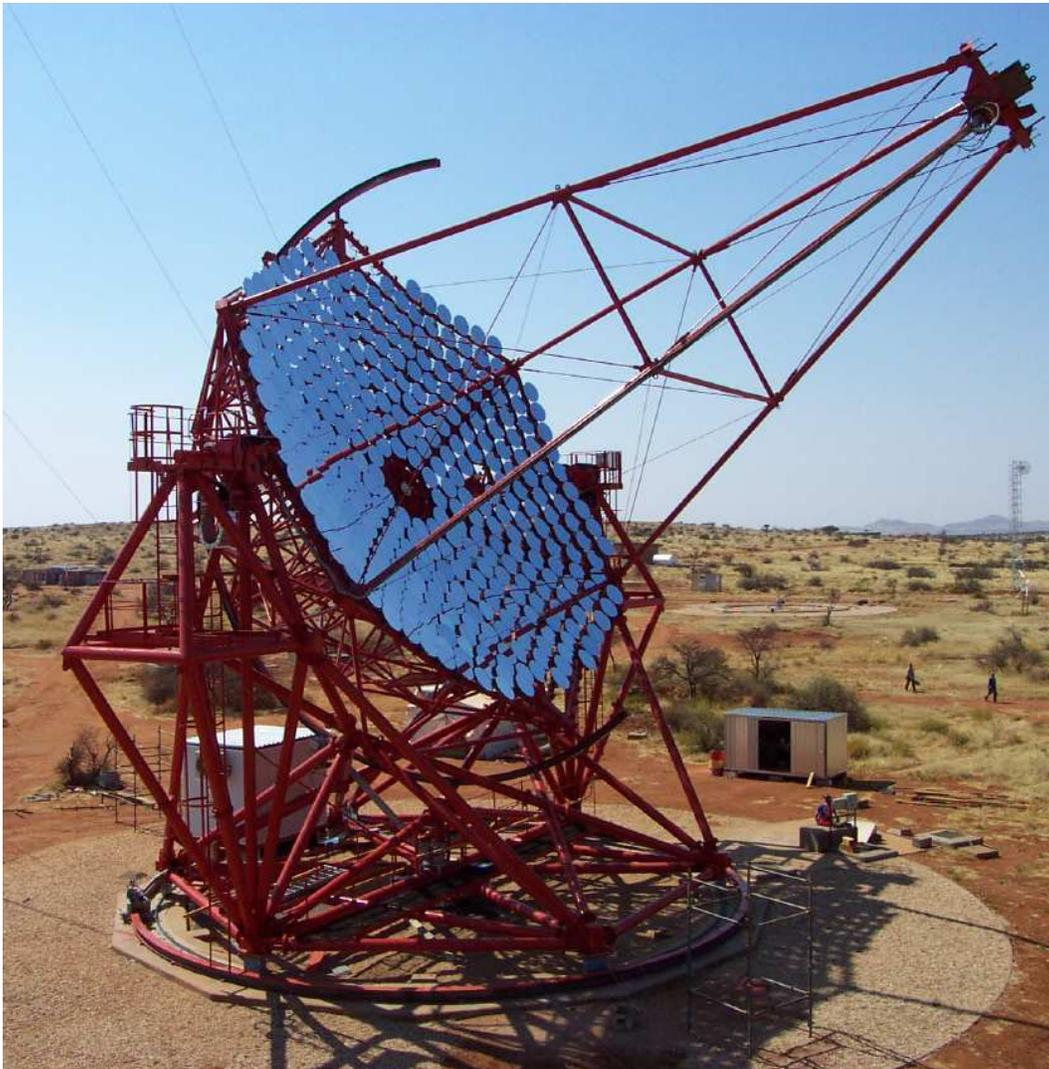
Abbildung 2.5: Das erste fertiggestellte Teleskop „CT3“, noch ohne Teleskopkamera. Am linken Rand des Bildes kann man im Hintergrund das Kontrollgebäude erkennen. Rechts im Bildhintergrund das Fundament für Teleskop „CT4“ und der Mikrowellen-Sendeturm zur Datenübertragung.
