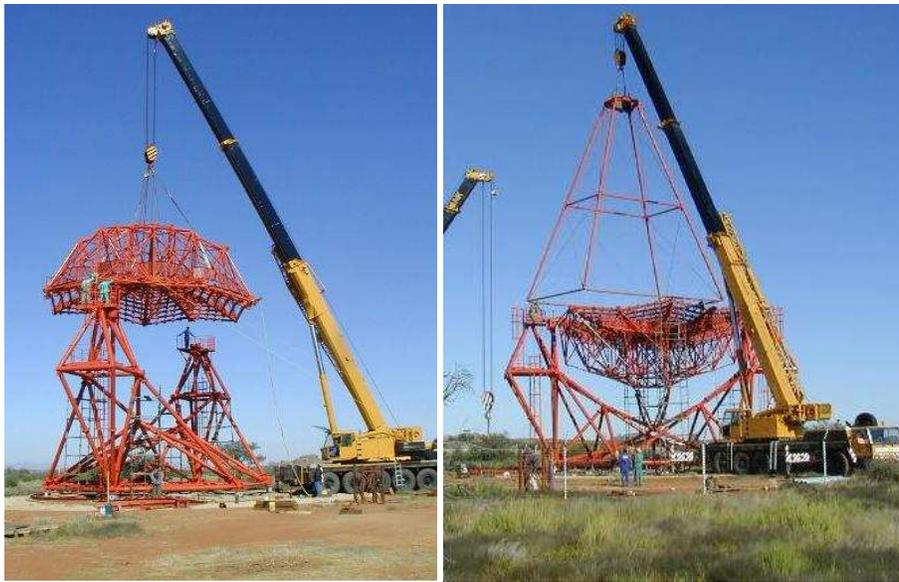
Abbildung 2.6: Zusammenbau einer Teleskopstruktur. Links: Nach vollständiger Montage der Basisstruktur und des Spiegelträgers, wird der Spiegelträger in die „Türme“ eingehängt. Rechts: Der Spiegelträger wird um  $180^\circ$  gedreht und der sogenannte Kamerabock mit den Kameraarmen aufgesetzt und montiert.
