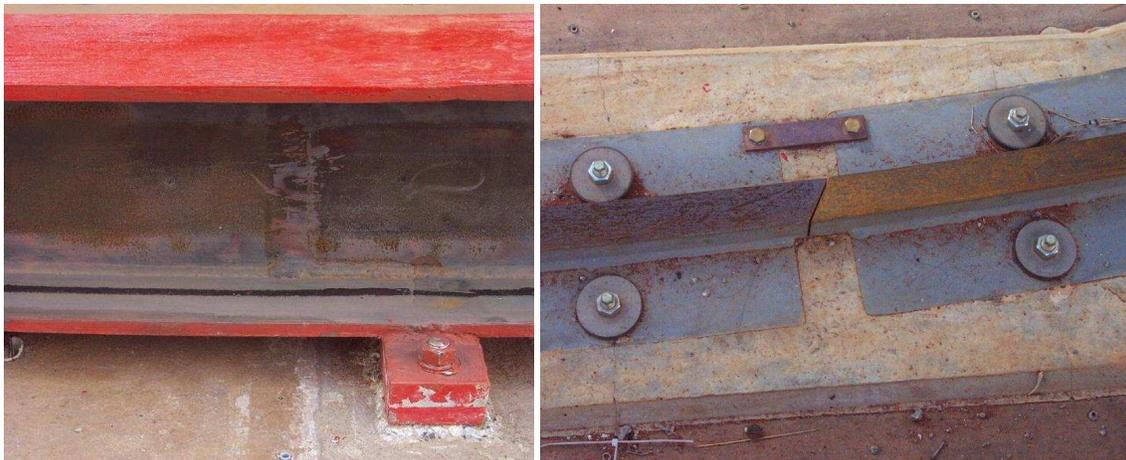
Abbildung 2.26: Unebenheiten auf den Azimutsschienen, links Schweißnaht auf der Azimut Antriebsschiene und rechts Stufe in der Laufschiene.
