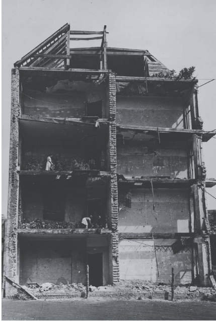
VII/1 Wohnhaus mit eingestürzter Seitenwand, 1946
