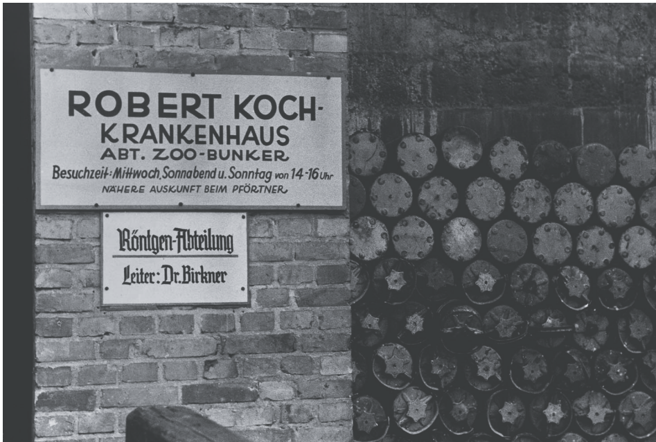
VI/1 Behelfskrankenhaus des Robert-Koch-Krankenhauses im Zoo-Bunker, Flakmunition lagert neben dem Eingang, 1945
