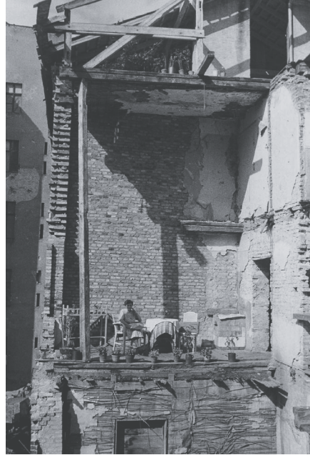
VII/2 Notbalkon in einer Hausruine, 1946
