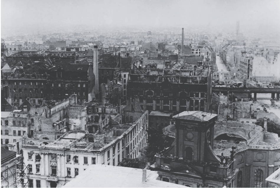
3 Blick vom Stadthaus Richtung Osten, im Vordergrund das teilzerstörte Palais Podewils und die Parochialkirche an der Klosterstraße, Bez. Mitte, 1945
