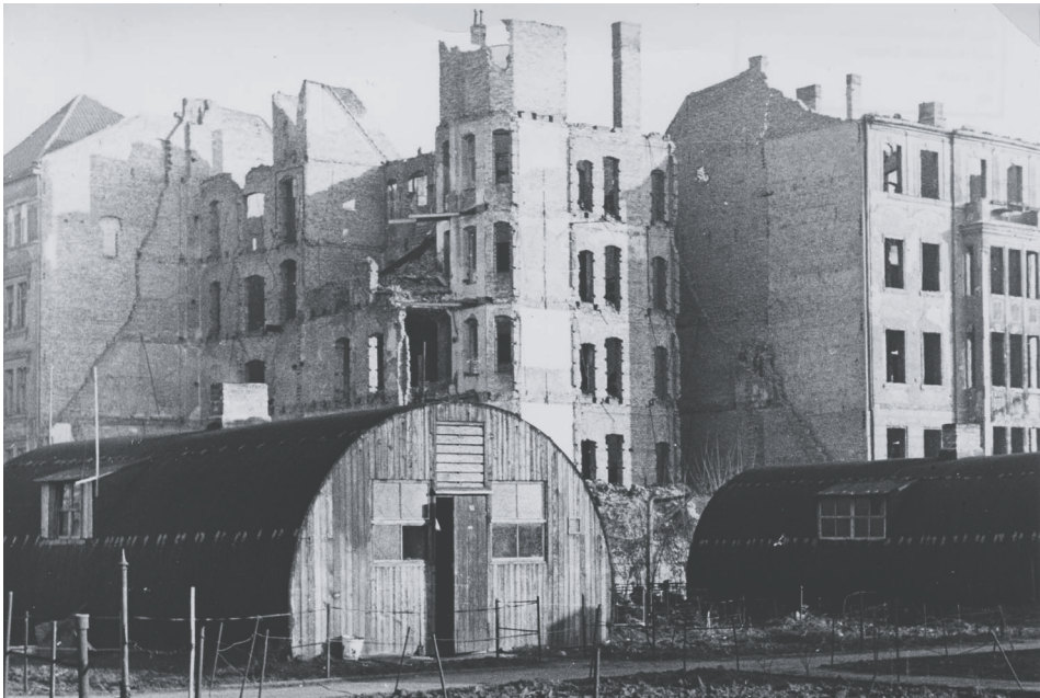
VII/4 Nissenhütten an der Wullenweberstraße im Bezirk Tiergarten, 1949
