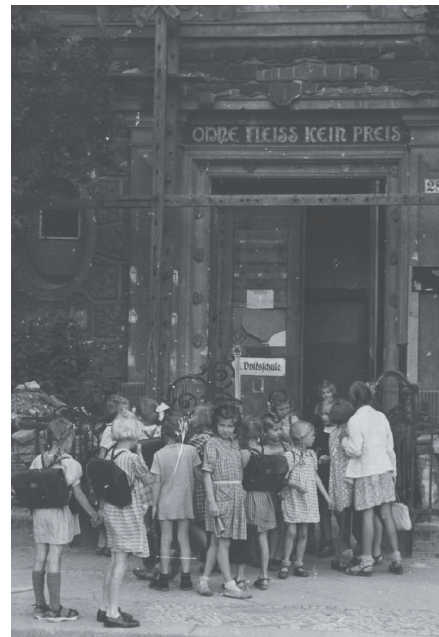
XI/3 Wiederaufnahme des Schulbetriebs in notdürftig instandgesetzten Schulhäusern, Juli 1945
