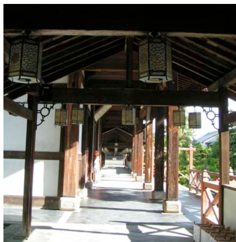
Abbildung 9: Die langen Flure des Manpukuji.
