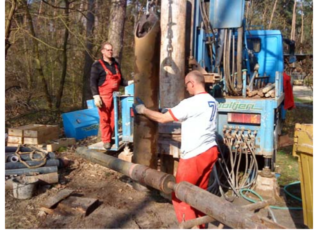
Abbildung 3-3: Einführen der Schappe zum Ausräumen des Bohrgutes aus dem verrohrten Bohrloch. Im Vordergrund: Schlagvorrichtung zur Gewinnung der Linerproben
