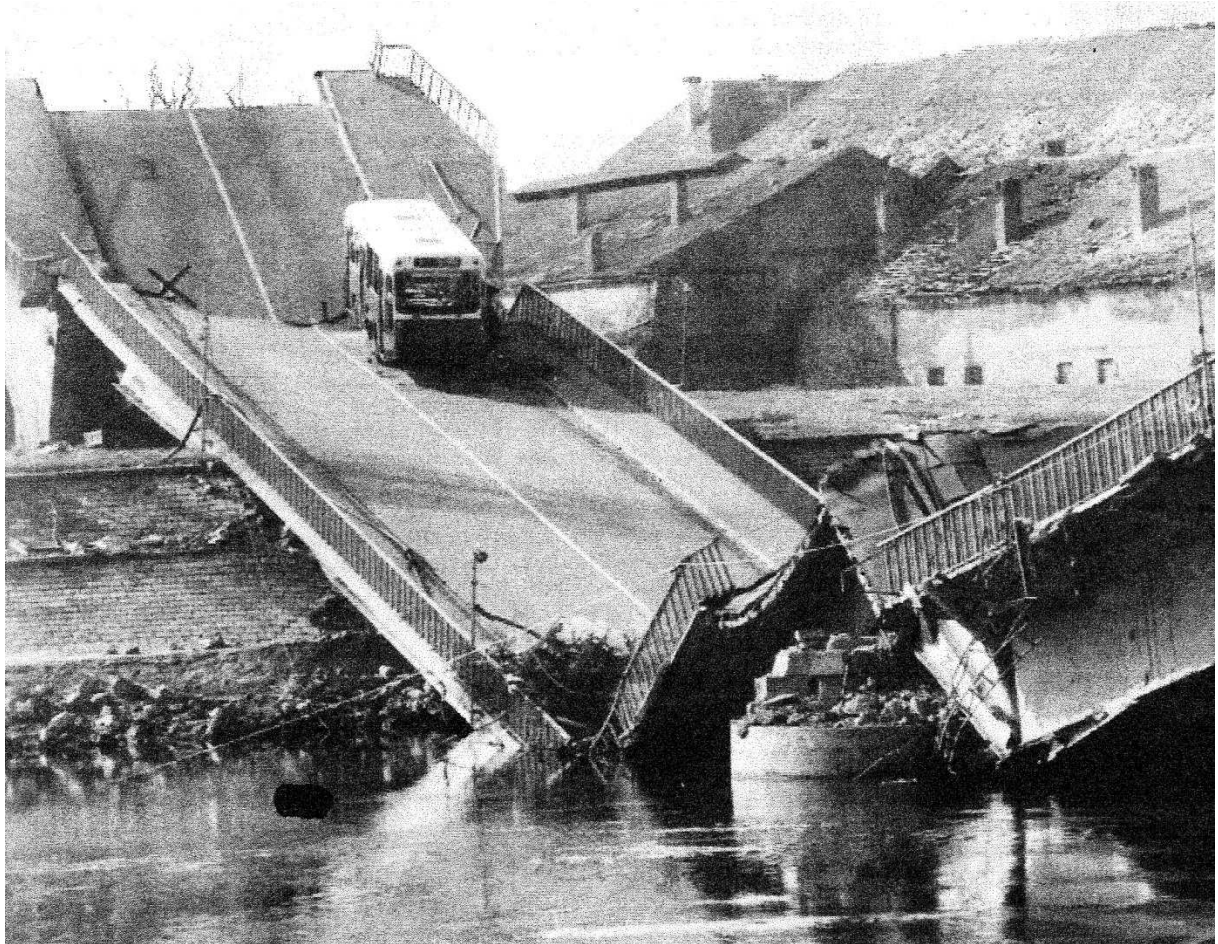
Abb. 29, Zerstörte Draubridge in Osijek, Februar 1992, Quelle: TOPIĆ/ŠPIŠIĆ, 1992, in: Hrvatska Krov, Osijek
