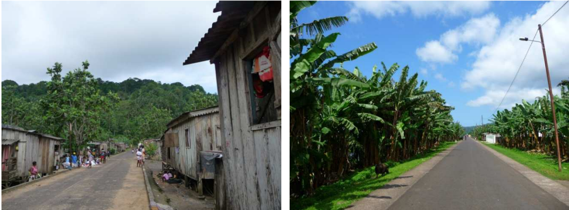
Abb. 124: Nationalstraßen von São Tomé – im Süden bei Porto Alegre (links) und im Norden bei Santa Catarina (rechts)
