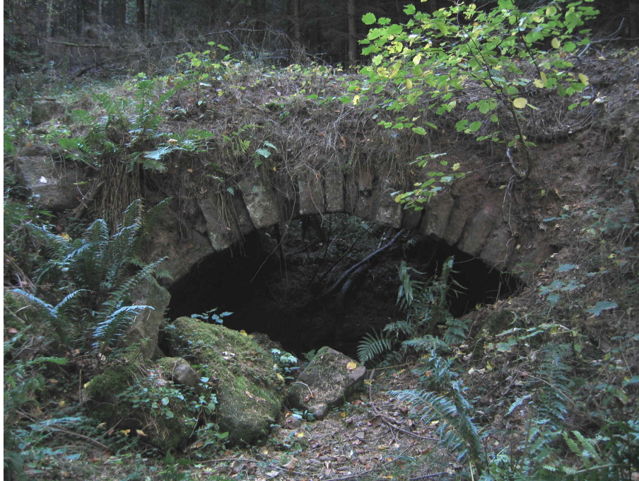
Fig. 19. Reste eines Gewölbes in Unterferdinandsdorf. Eigene Aufnahme von 2005.
