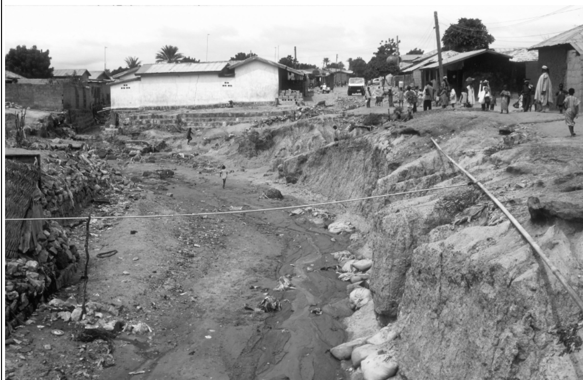
Abbildung 6-1: Gully in Tudun Wada South zerstört Straße und isoliert Stadtteile
