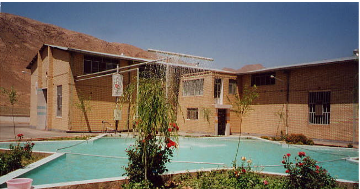
Abb. 34 Der Hof der Rosenwasserproduktionsanlage
