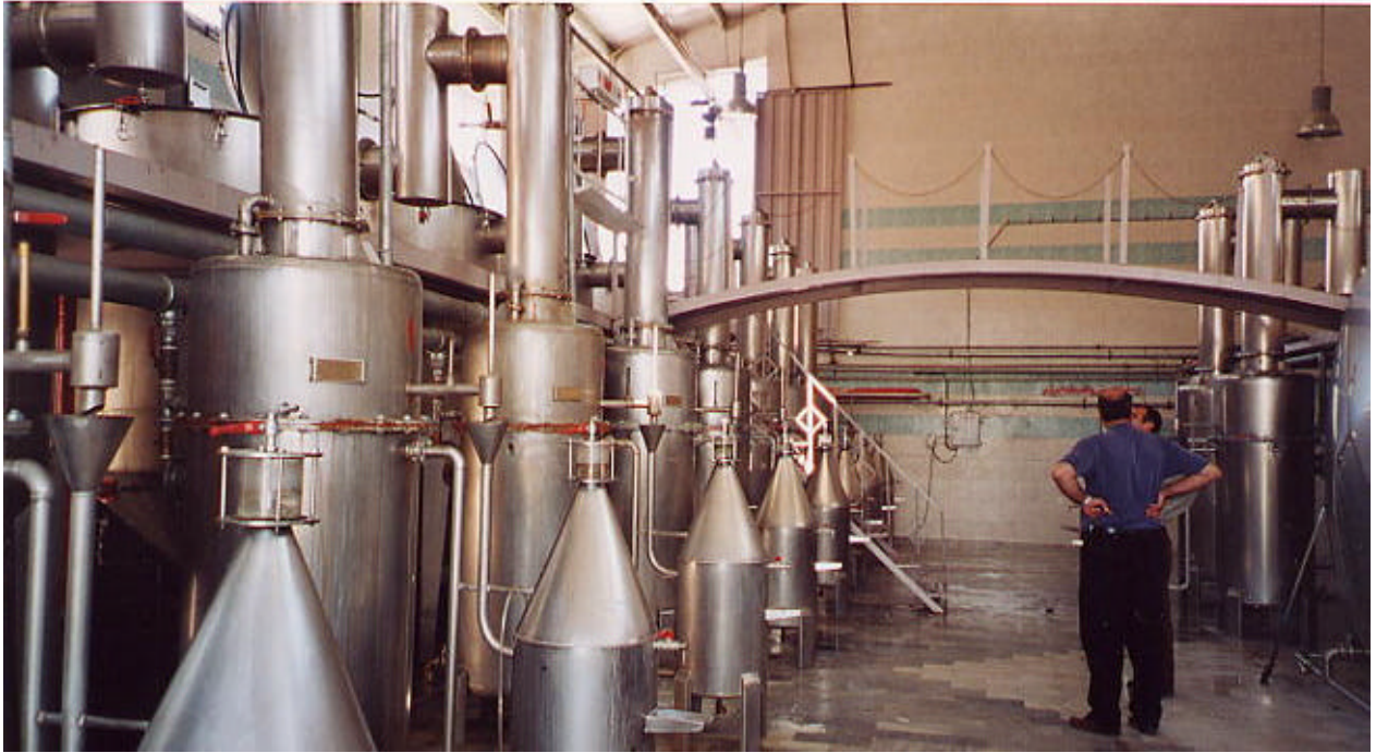
Abb. 35 Die Destillationsanlage der Fabrik
