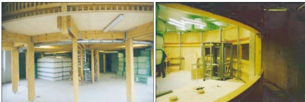
Abbildung 1.5: Das ringförmige Heidelberger AEOLOTRON (Durchmesser: 10 m) während der Bauphase im Mai 1999. Die Wasserrinne mit einer Breite von 60 cm ist mit einer 9 cm dicken Styrodurschicht isoliert um den Wärmeverlust im Kanal so gering wie möglich zu halten. Quelle: [JÄHNE et al. 1999].
